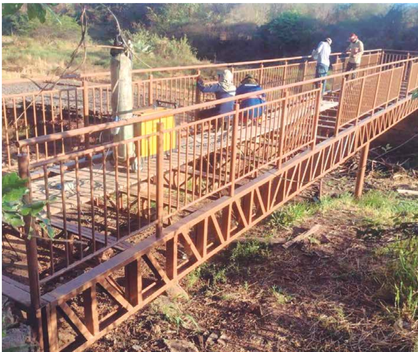
Visitantes poderão usufruir com mais conforto do passeio pelo Vale; uma terceira passarela está em análise
