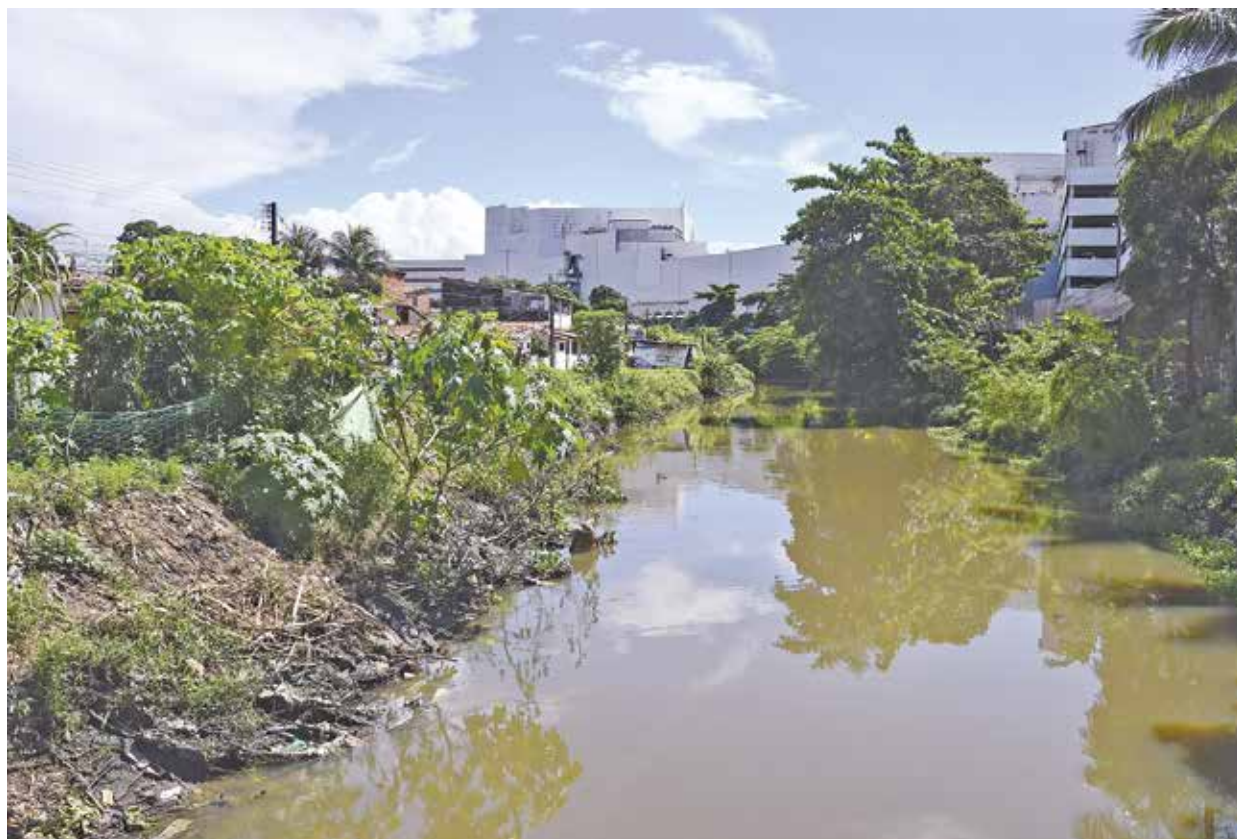
O projeto de revitalização do Rio Jaguaribe está sendo executado pela Prefeitura de João Pessoa
